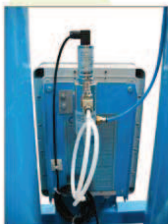
Coffret avec sonde hygrométrique Pilotage EV 24 V
